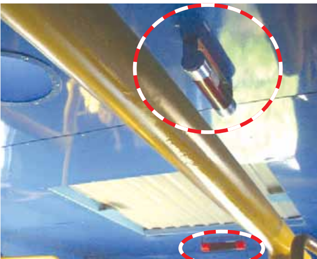
Εφαρμογή της αμπούλας BONPET σε οροφή μηχανοστάσιου
